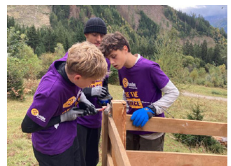
Es wurde gesägt und genagelt ...
